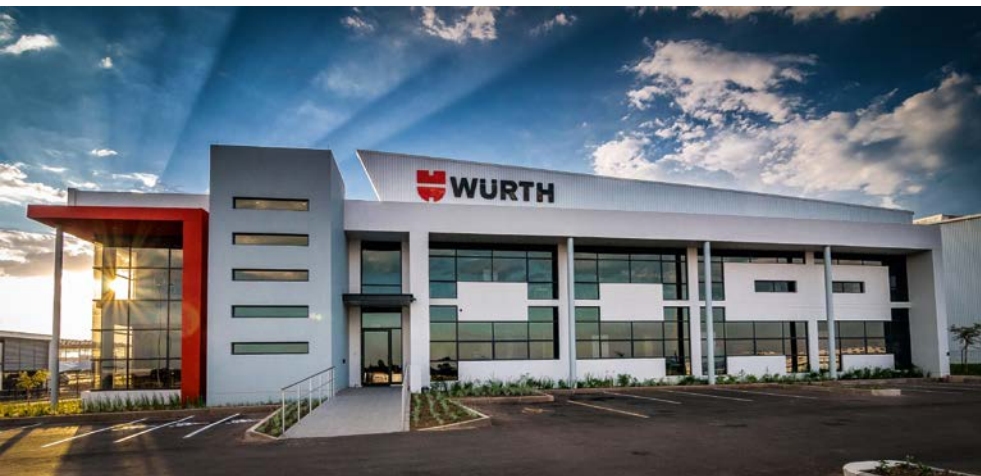
Wuerth South Africa (Pty.) Ltd. en Gauteng, Sudáfrica
